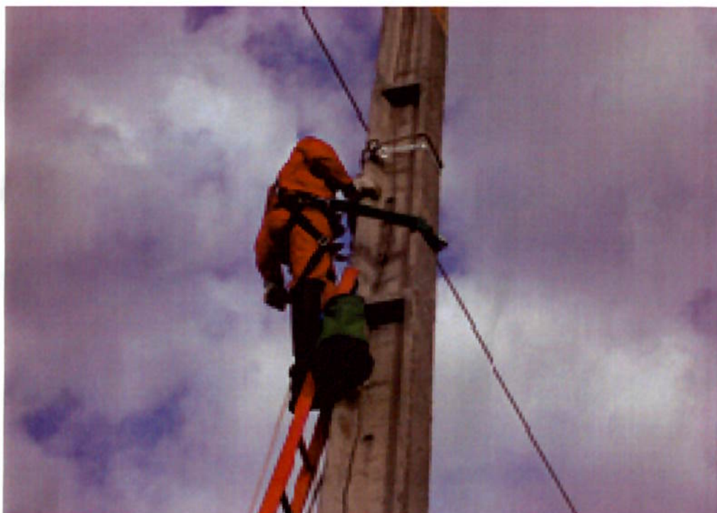
Figura 5 – Funcionário instalando os grampos de sustentação nos postes
