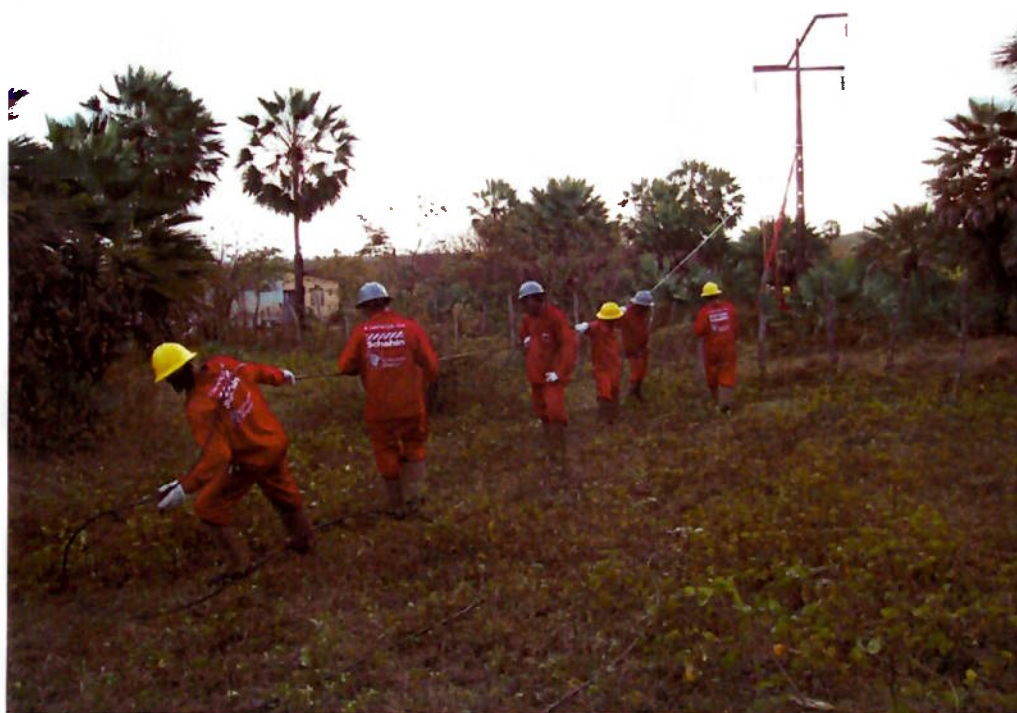
Figura 7 – Cabo puxado para marcação de acessórios
