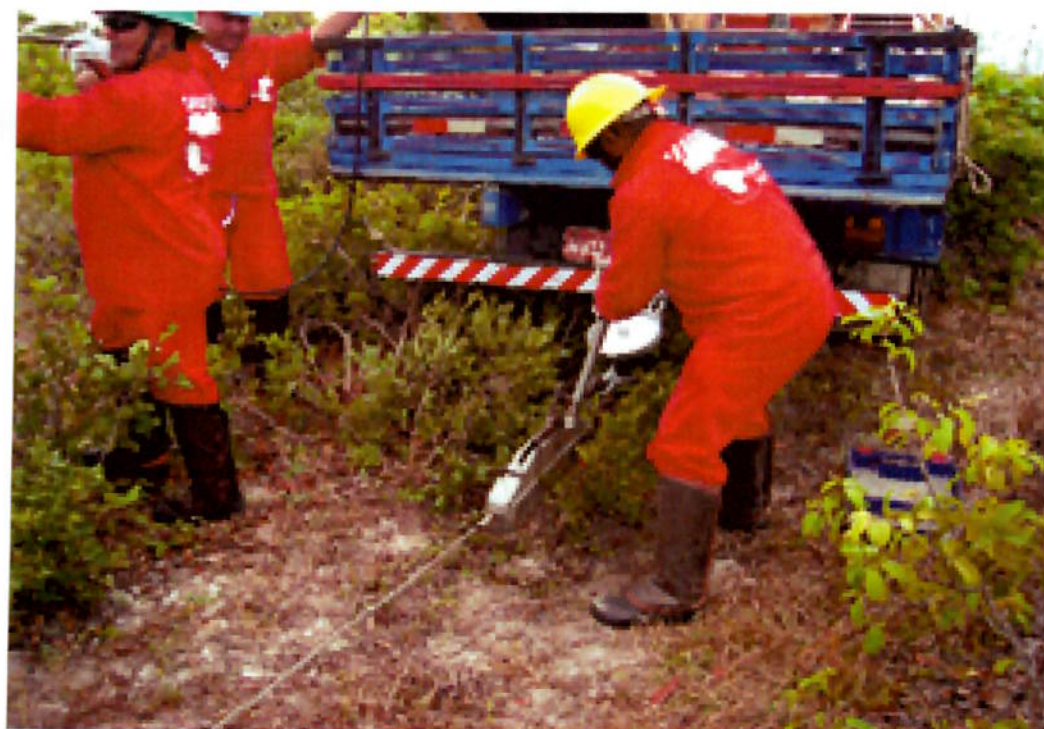
Figura 8 – Cabo sendo tensionado com titor e dinamômetro
