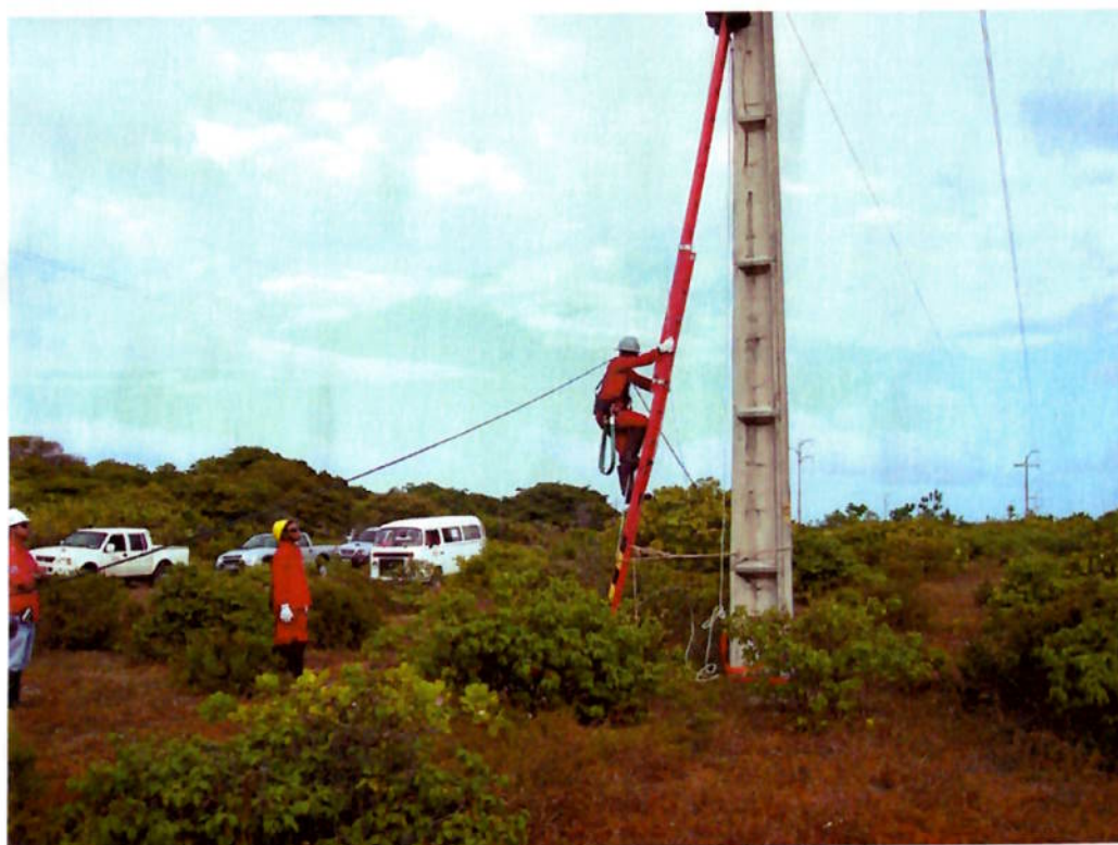
Figura 6 – Cabo levado para ser fixado no grampo de sustentação.
